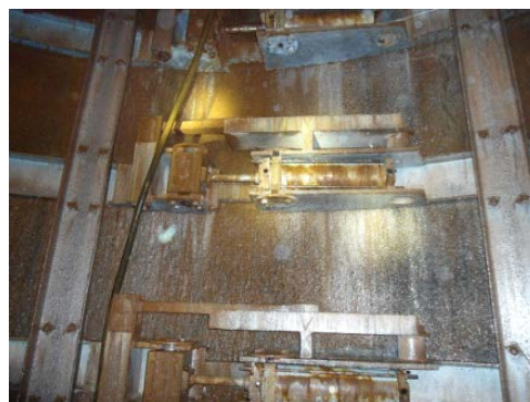
Rys. 11. Widok siłowników hydraulicznych rozpierających pierścienie
