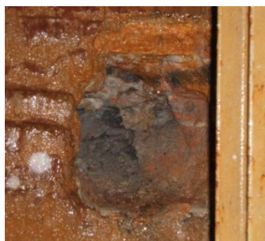
Rys. 2. Podkucie technologiczne po starym dźwigarze
