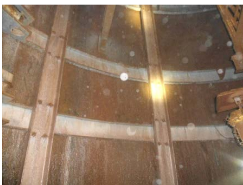
Rys. 10. Widok pierścieni wzmacniających obudowę szybu
