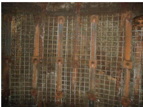
Rys. 5. Kawerna zabezpieczona przykotwioną siatką stalową z okładzinami
